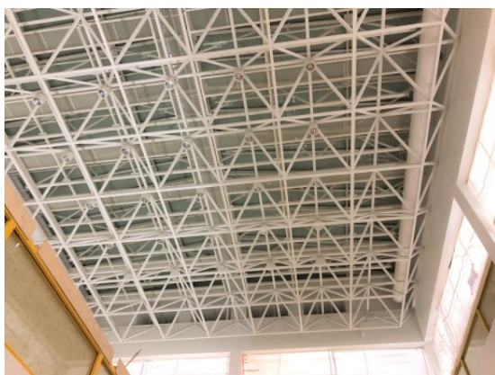
Valoaukon vanhan kattoristikko on saanut uuden maalin päälle.
