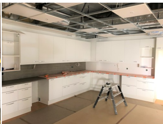
Uusi taukokeittiöä asennetaan 2.krs. B-lohkolla.
