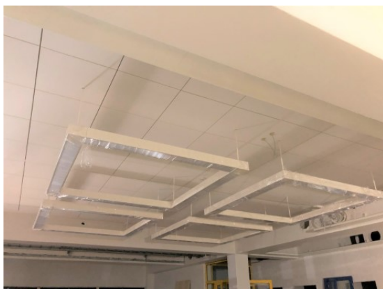
Saneerattuja valaisimia paikalleen asennettuna
