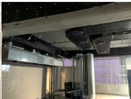
Keittiön IV-kanavointityöt käynnissä
