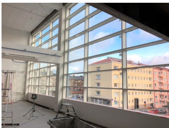
Uutta ikkunapintaa Seminaarinkadun puolelta.
