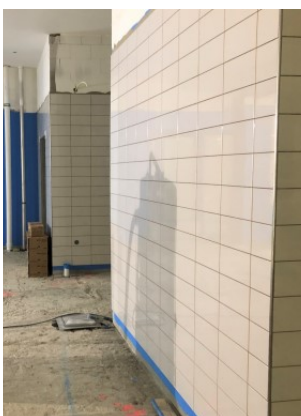
Valmistuskeittiön laattatyöt käynnissä.
