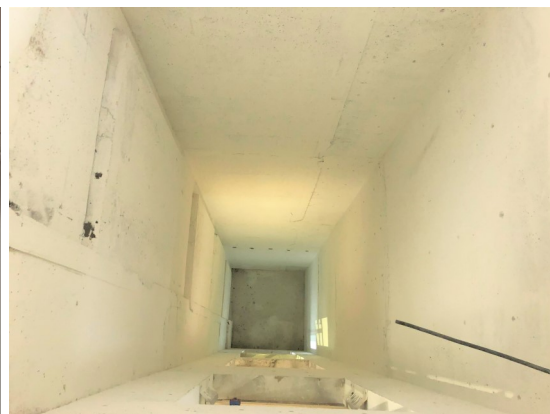
Uuden tavarahissin asennus käynnistyy viikolla 41.
