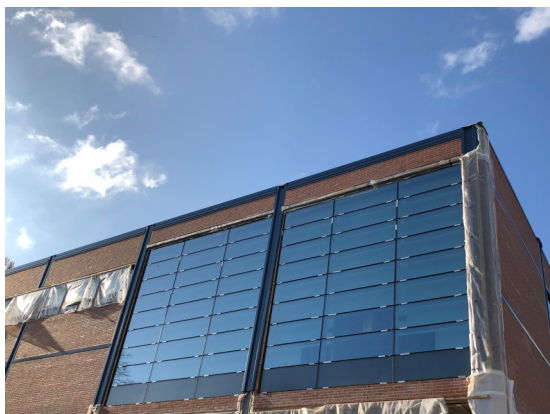
Uutta ikkunapintaa Seminaarinkadun puolelta.
