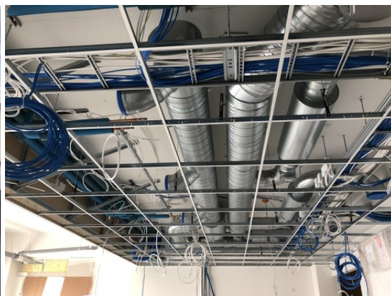
Talotekniikan asennukset jatkuvat.
