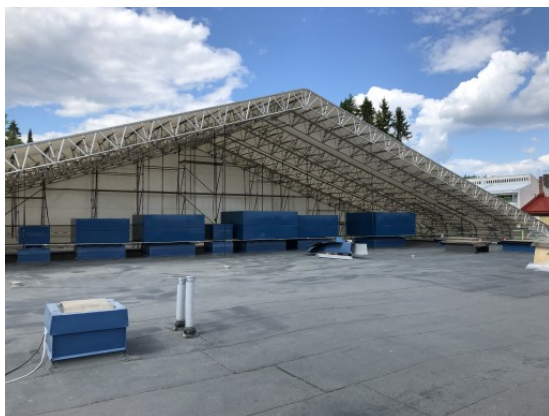
Sääsuojan purkutyöt ovat käynnissä.
