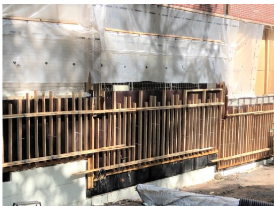
Tällä viikolla valettiin lounaan puoleiset uudet sokkelikuoret.
