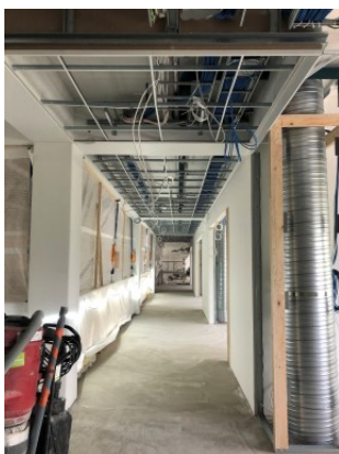
Lattian tasoitetyö valmistelut käynnissä.
