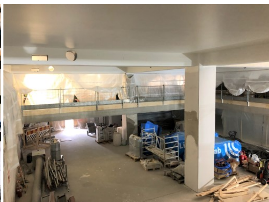
Pohjakerroksen uutta aulatilaa.
