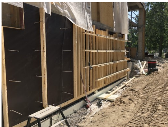
Sokkeliulkokuorien valumuottia
