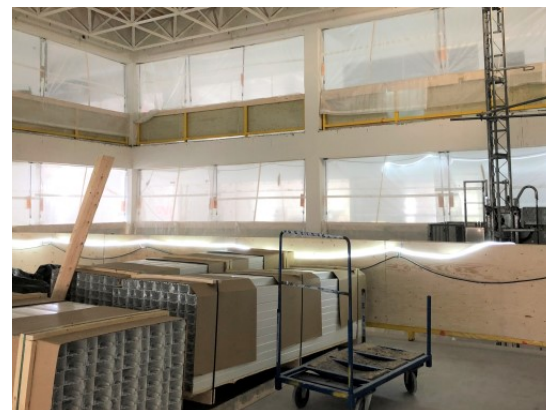
Osastointityöt jatkuvat sisällä.
