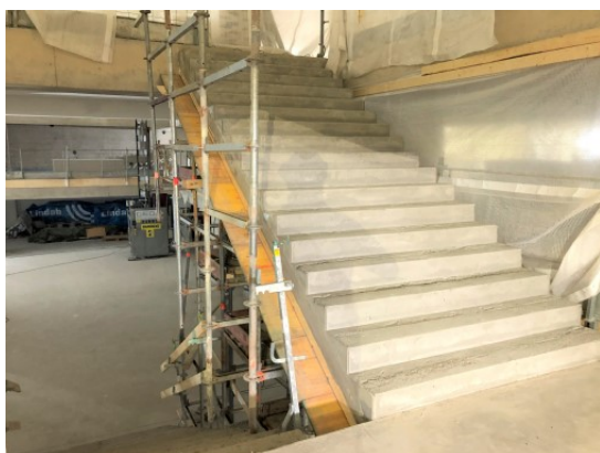
Uutta sisäporrasta valmistumassa.
